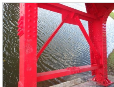
鋼製脚補強、ストラッドを新規に交換
